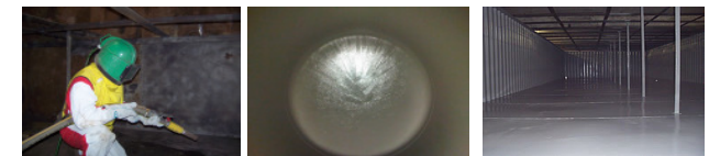
Sandstrahlen und Beschichten von Druckluftwasserbehälter und Wasservorratsbehälter
